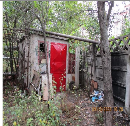
Corp clădire bransament la rețeaua termică
